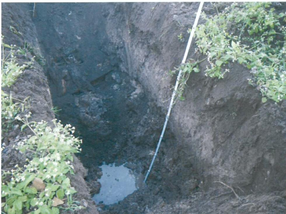
Foto 23. Particolare del fronte di scavo del pozzetto esplorativo P03 che si è spinto fino ad una profondità di 1,6 m dall'attuale piano campagna.
