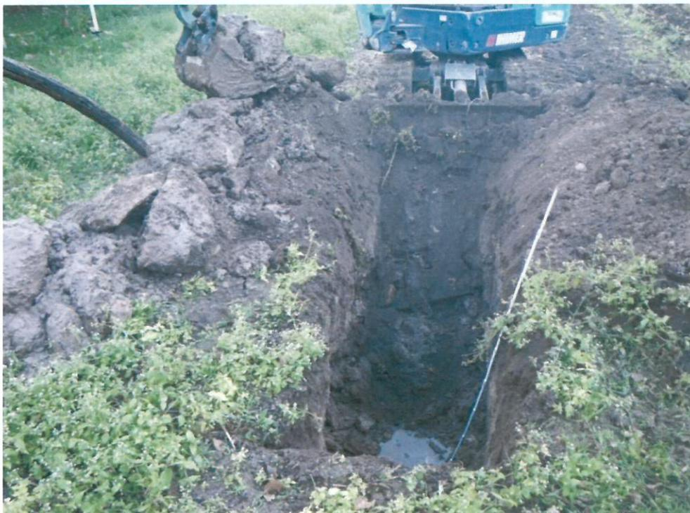
Foto 11. Particolare del materiale di risulta del pozzetto esplorativo P03.
