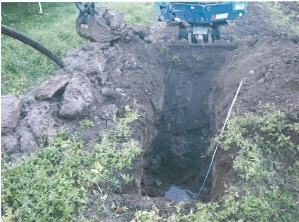
Foto 24. Particolare del materiale di risulta del pozzetto esplorativo P03.
