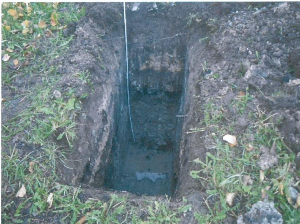
Foto 17. Particolare del fronte di scavo del pozzetto esplorativo P01 che si è spinto fino ad una profondità di 1,8 m dall'attuale piano campagna.
