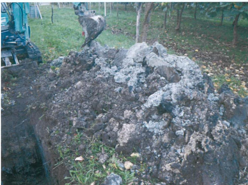
Foto 18. Particolare del materiale di risulta del pozzetto esplorativo P01.
